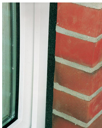
Le guarnizioni sigillanti coprifuga G.U sono precomprese fino a meno del 20 % dello spessore originale
